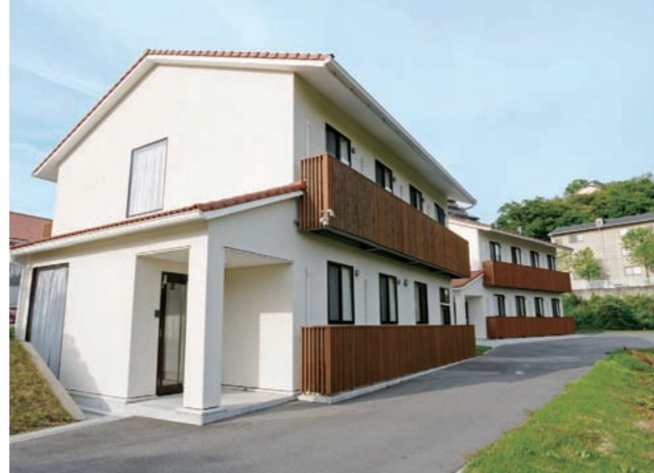
2012年の第1棟に続き、2014年に第2棟が完成しました。
